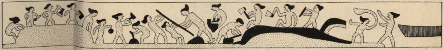
Bai 73 Va Kanalgraben.
