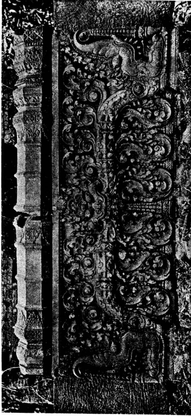
PRASĀT KŌK PŌ. — Lintean N., frise du lintean N., et colonnette du sanctuaire B.
